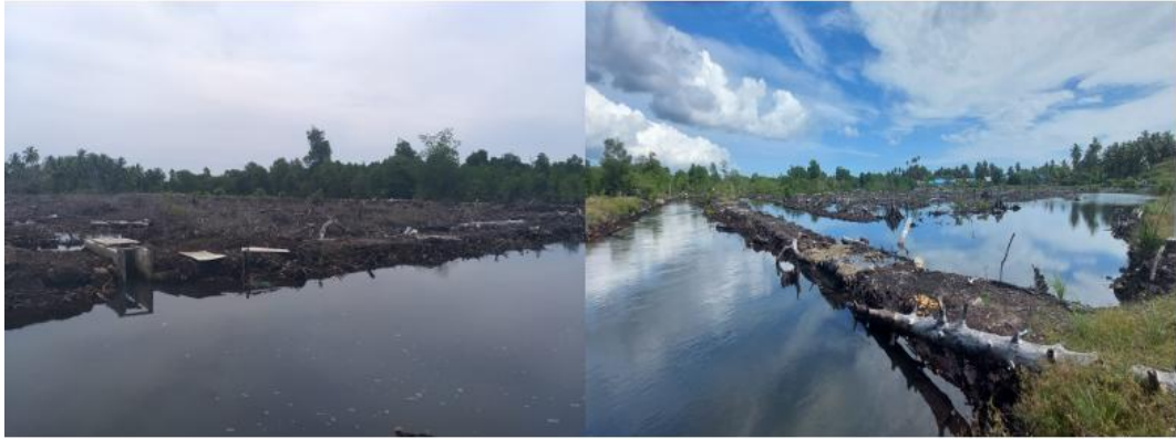
Gambar 5.1. Kondisi pematang tambak pada saluran sekunder di Desa Watuondo.
